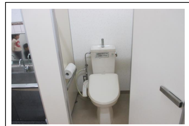
●2階トイレ（保育所と共有） 大便器（洋式）1台
