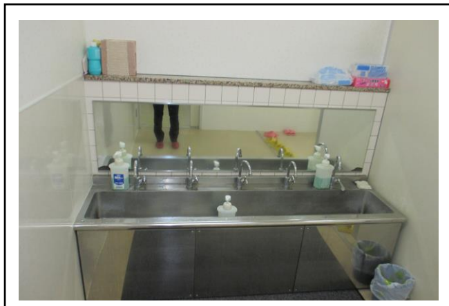
●2階トイレ（保育所と共有） 流し台
