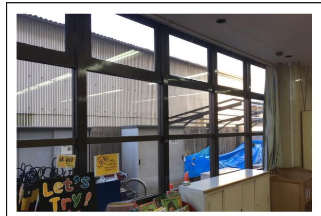
●健診室（開閉ができない窓）
