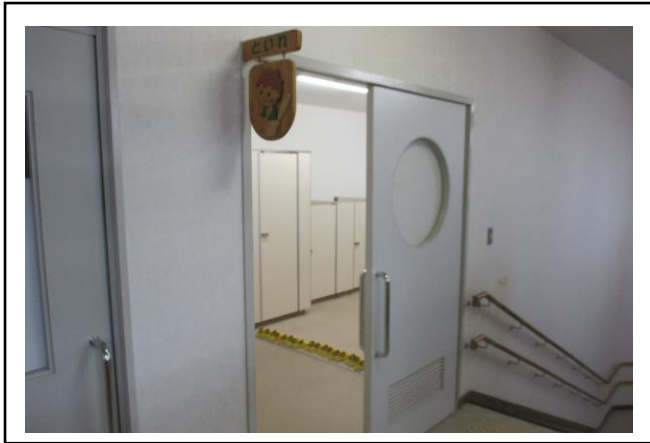
●2階トイレ（保育所と共有） 入口
