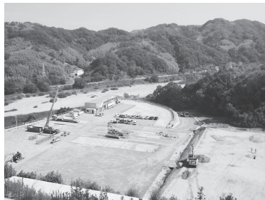
工事着工(平成28年5月)
