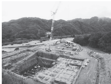
ごみピット掘削工事(9月)
