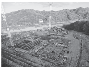
基礎コンクリート打設工事(12月)
