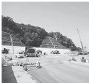
工事着工(平成28年5月)
