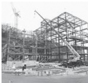
施設鉄筋建方工事(平成29年3月)
