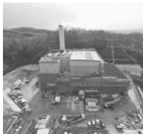
外壁塗装工事(平成29年12月)
