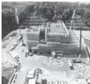
外壁建込工事(平成29年8月)
