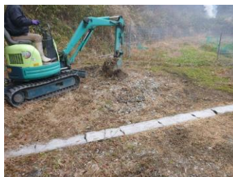
畑の排水設置作業
