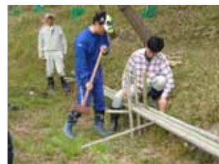
竹のベンチは斜面を活かし、竹を打込み、組み合わせ、編みこんで作成。
