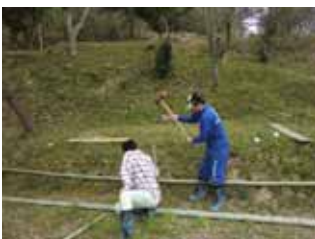
竹のベンチは斜面を活かし、竹を打込み、組み合わせ、編みこんで作成。
