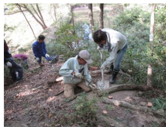
遊歩道の補修
