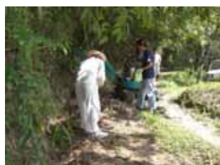
イノシシに荒らされた水路の復旧
