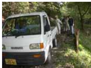
崩壊した道路の復旧
