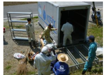
棚をコンテナに設置して完成！
