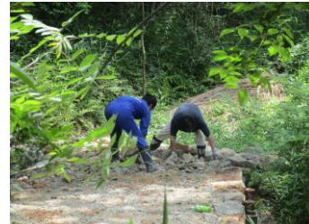
池の周りのぬかるみの補修
