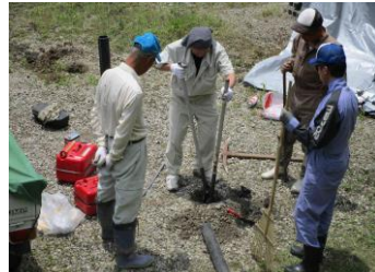
雨除け屋根設置作業
