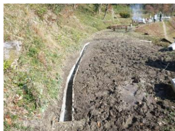
U字溝の設置完了！
