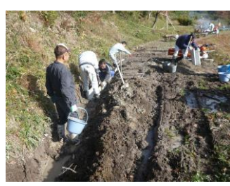
溝にU字溝を設置 →
