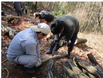
ドリルで穴をあけます
