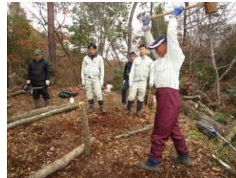
木を打ち込みベンチづくり
