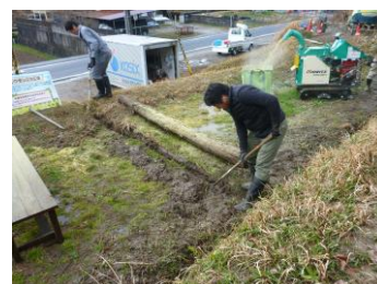
広場の水路の整備
