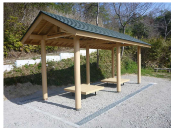
休憩所の外構工事も完了しました
