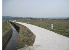
農道コンクリート舗装工事(里)
