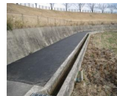
農道アスファルト舗装補修工事(菅井)
