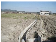
水路更新工事(素掘り水路をコンクリート製水路へ)(植田)
