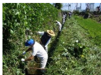
水路草刈り泥上げ(全集落)
