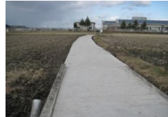
農道コンクリート舗装工事(中)
