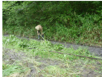
詰まった側溝から泥をさらいます
