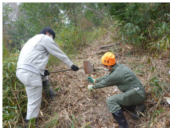
朽ちた階段も杭を打ちなおして・・・
