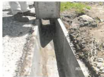
水路補修工事(南)一目地・マス補修
