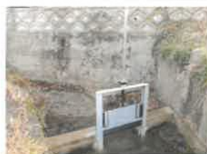
水路ゲート(堰)補修工事(植田)
