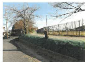
蓮池堤体防草シート張工事(植田)
