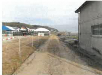
農道補修工事(谷)一鋤取り
