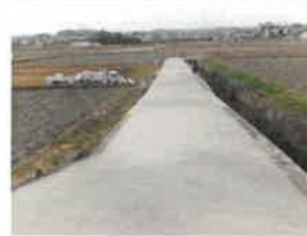
農道アスファルト補修工事(菅井)
