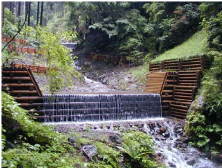
木製治山ダム
