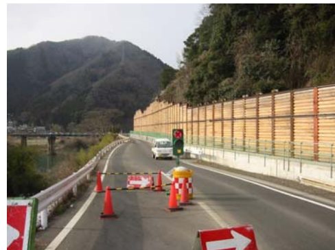
木製仮設防護柵
