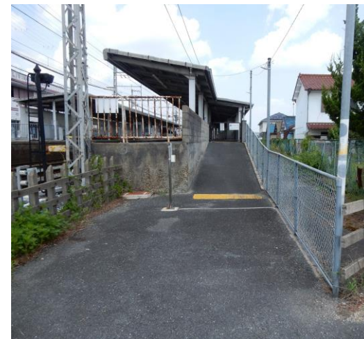
< 近鉄狛田駅 > ～車いす用スロープ～
