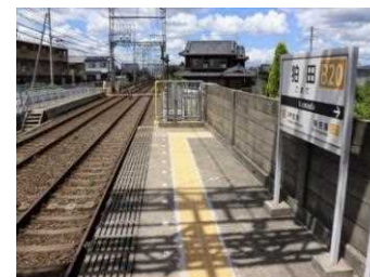
ホーム端部 (警告色の塗布)
