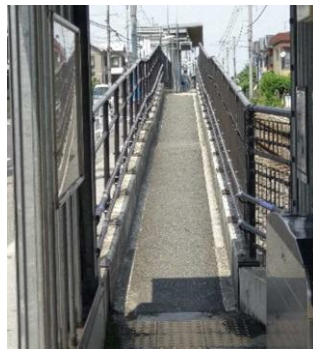
<図 14 下粕駅のスロープ>
