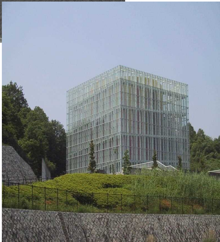
【華の塔配水池】
