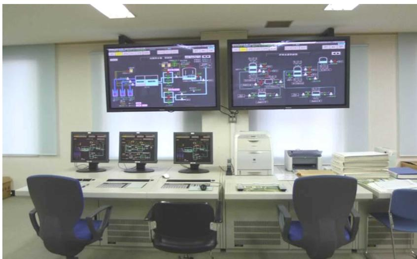
写真 6-3 上下水道部事務所 2 階にあるグラフィックパネル（遠方監視盤）
