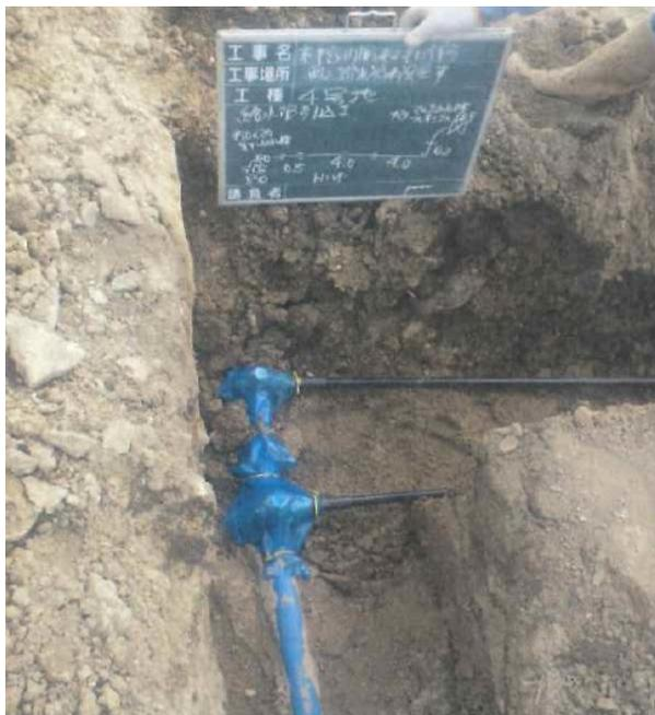
HIVEP  $\phi$  20 mm給水管の布設
