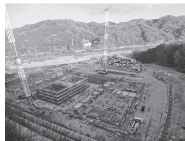
基礎コンクリート打設工事（12月）
