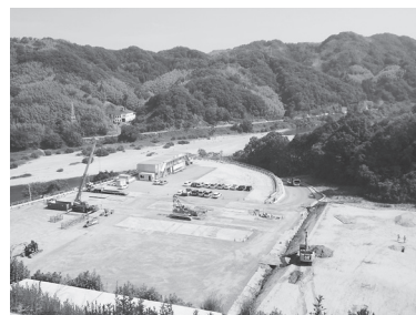
工事着工（平成28年5月）
