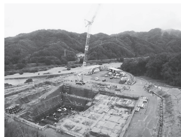
ごみピット掘削工事（9月）
