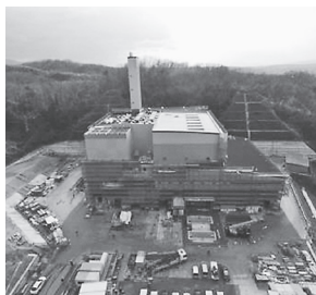
外壁塗装工事(平成29年12月)
