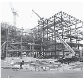
施設鉄筋建方工事(平成29年3月)
