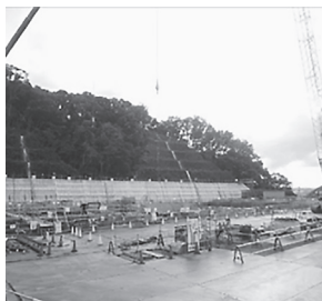
ごみピットコンクリート打設工事(平成28年10月)
