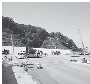
工事着工(平成28年5月)
