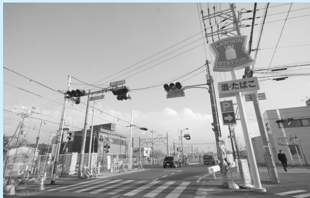
完成した踏切連動信号
