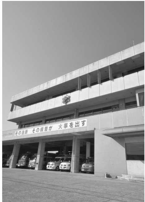
建て替えに直面している消防庁舎
