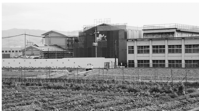
建て替え工事が進む川西小学校
