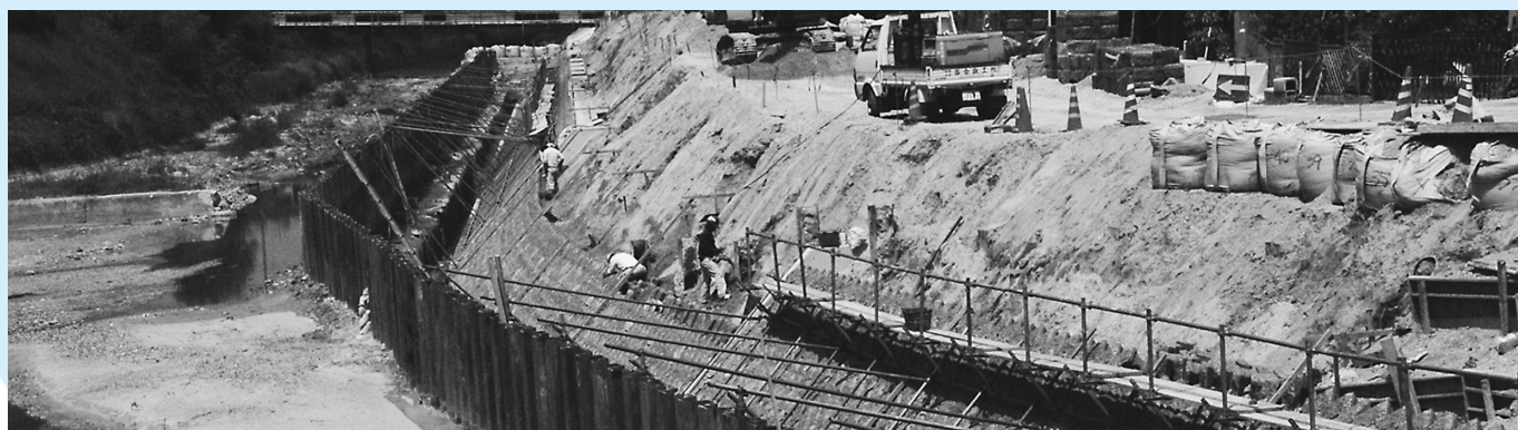
整備中の煤谷川
