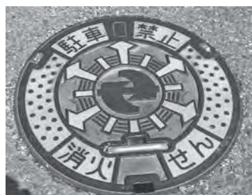
消火栓のマンホール
