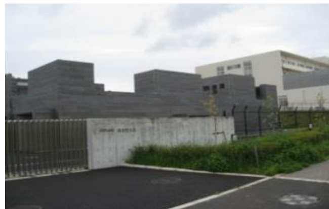
植田受水場 平成20年築造 受水池 2,600m 3 (1,300m 3 ×2池) 送水ポンプ 4基
