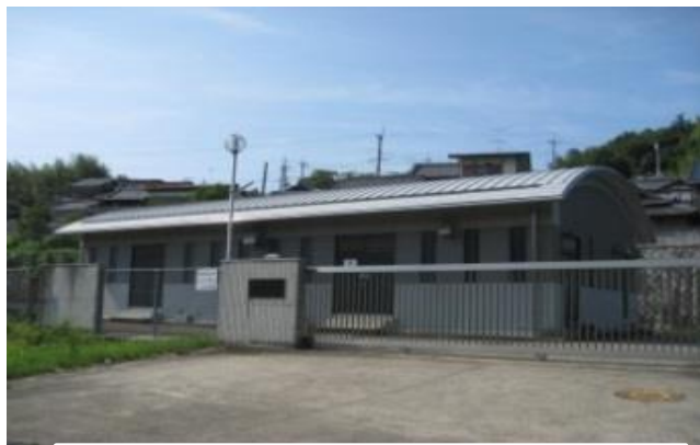
柘榴浄水場 平成9年築造 送水ポンプ 2基、浄水池 332m 3 深井戸 2本
