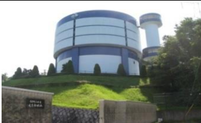
光台配水池 平成4年築造 2,800m 3 緊急貯水槽 100m 3
