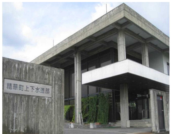
写真 1-1 精華町上下水道部の正面玄関
