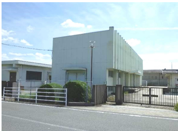
写真 4-2 北稲浄水場全景
