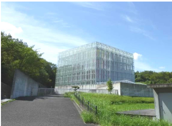
写真 4-22 華の塔配水池(容量:4,060m 3 )
