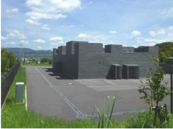
写真 4-18 植田受水場全景
