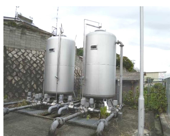
写真 4-11 急速ろ過機
