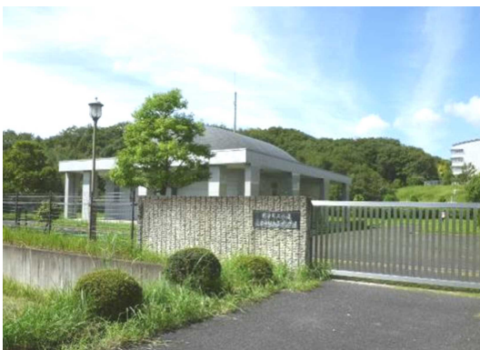
写真 4-28 光台中継加圧ポンプ場全景
