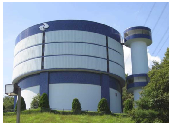
写真 4-23 光台配水池(容量:2,800m 3 )
