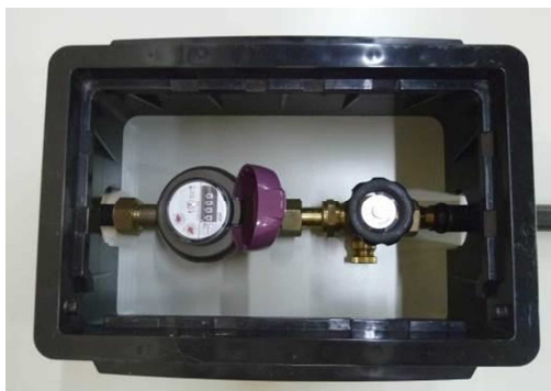
写真 4-37 一般家庭用水道メーター設置例 写真 4-38 止水栓 左:旧型 右:新型
