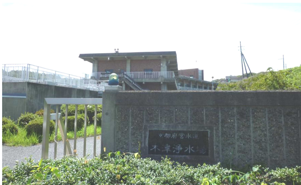
写真 4-36 京都府木津浄水場の正面入口
