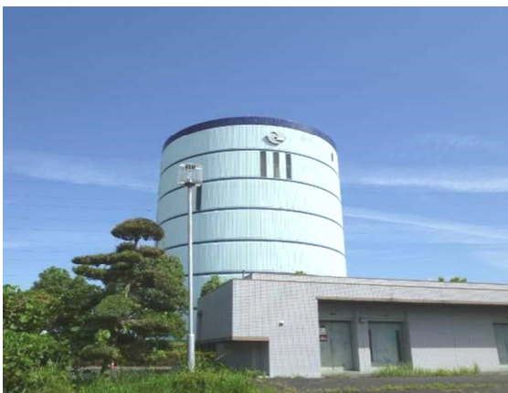
写真 4-24 桜が丘配水池(容量:2,510m 3 )
