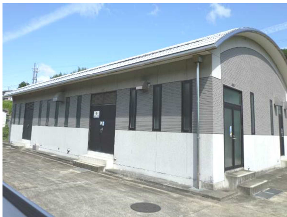
写真 4-8 柘榴浄水場全景
