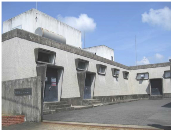
写真 4-14 祝園受水場全景
