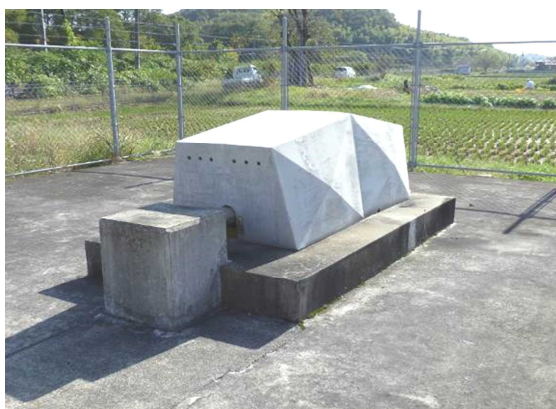
写真 4-34 旭第1 浄水場 取水井
