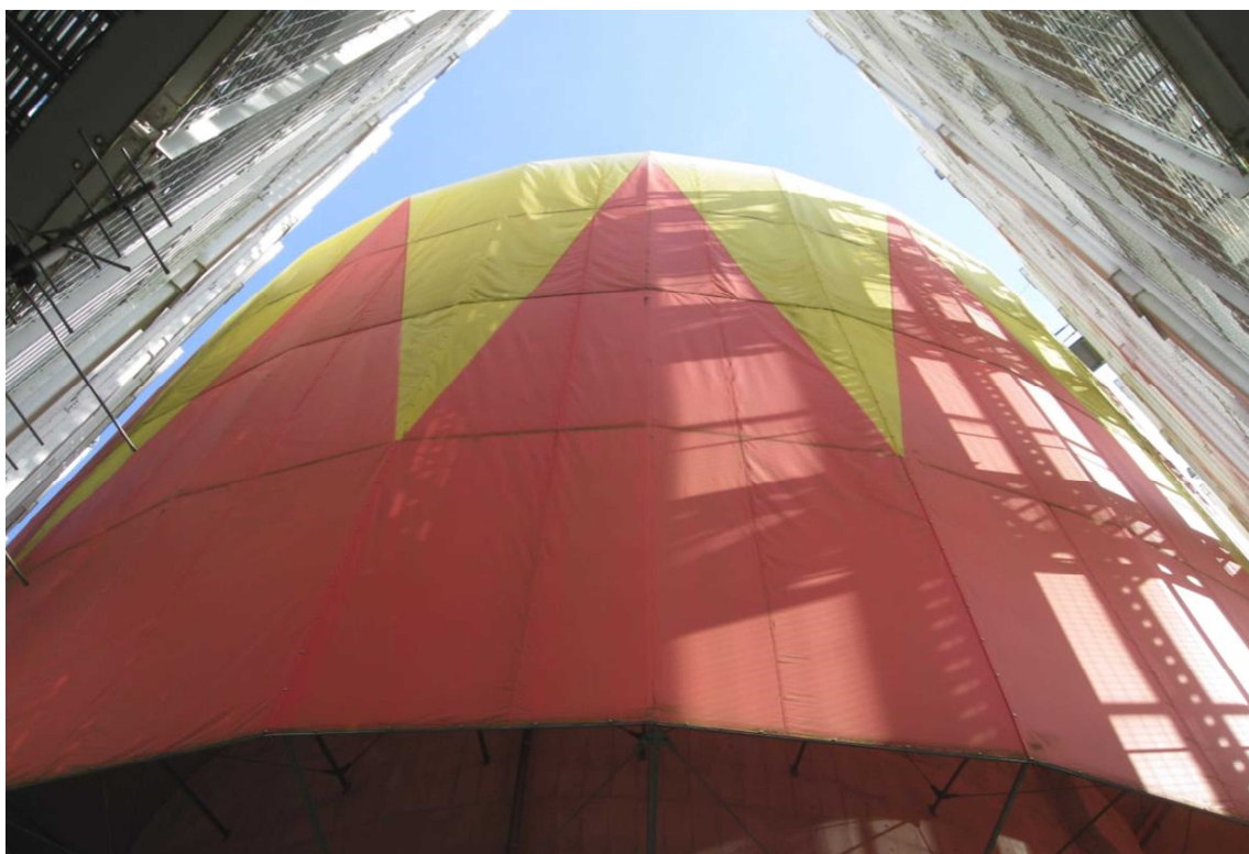
写真 6-2 華の塔配水池（外壁の内側から撮影）
