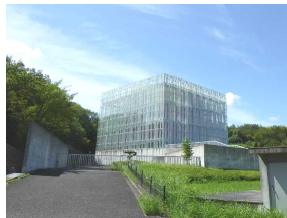
写真 6-8 華の塔配水池
