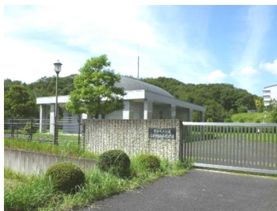
写真 6-10 光台中継加圧ポンプ場
