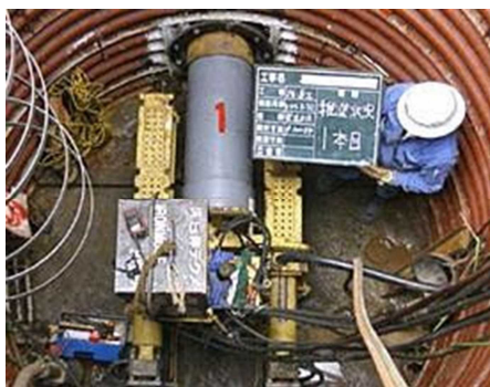
[図 4]発進立坑内状況(参考)
