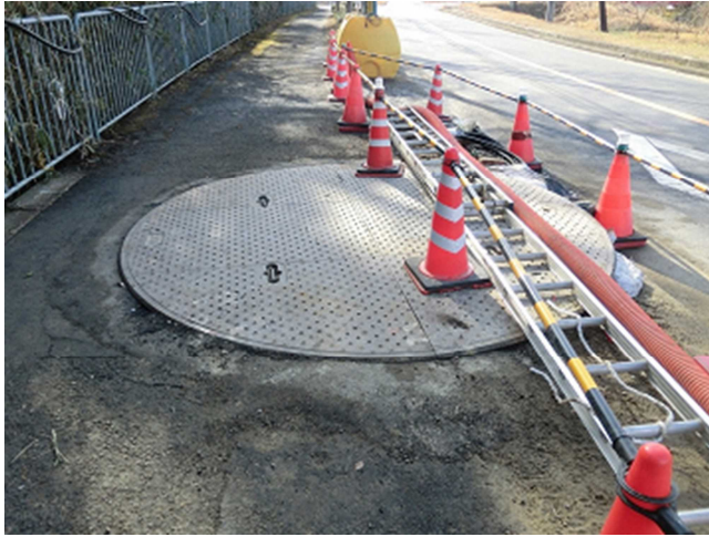
発進立坑(覆工板設置状況)
