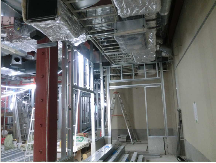
内装・設備工状況
