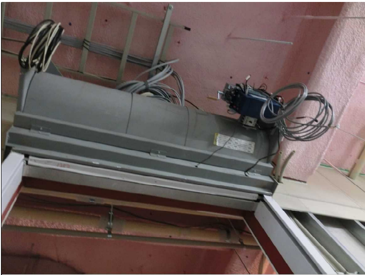
電動シャッター取付
