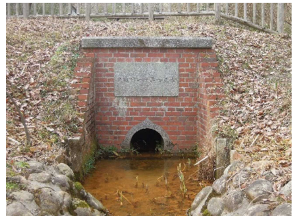
永谷隧道坑口（復元）
