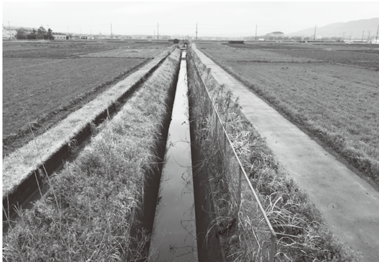
改良工事される新川 (建設課より)
