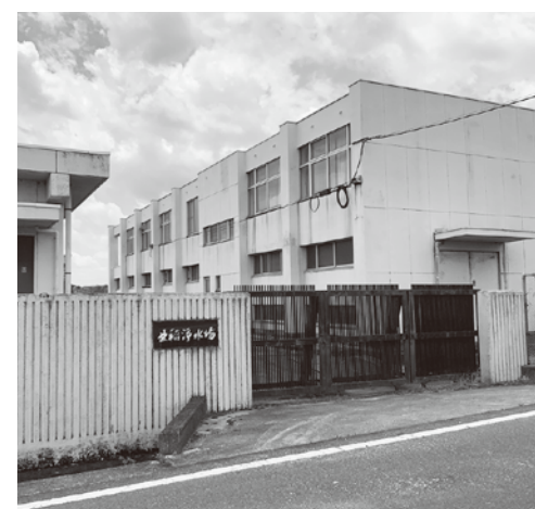
旧耐震基準の北稲浄水場管理棟
