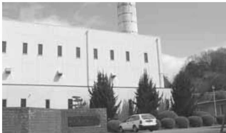
老朽化した環境センター
