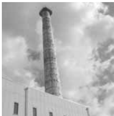
老朽化した環境センター
