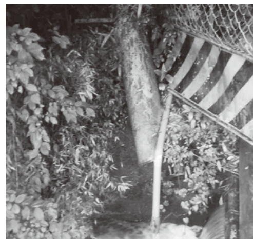
調整池からの排水
