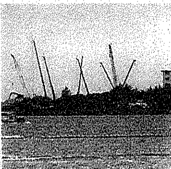
辺野古の普天間飛行場移設施設の建設工事
