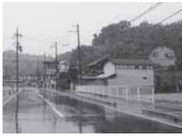
河川改修工事
