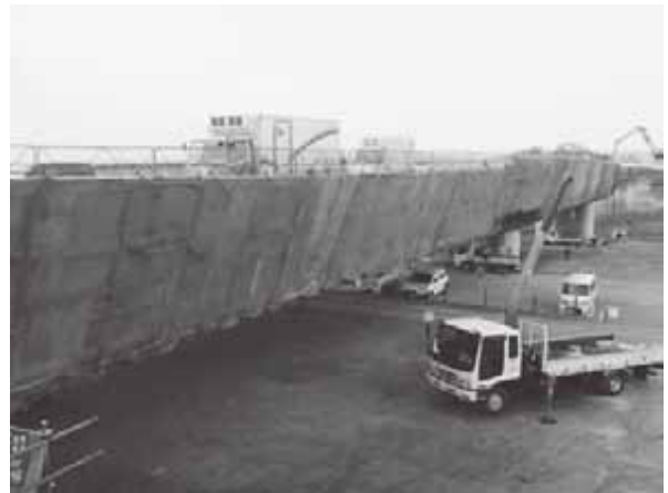
工事中の開橋
