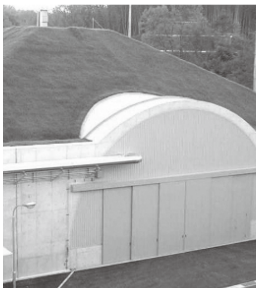
地上覆土式火薬庫
