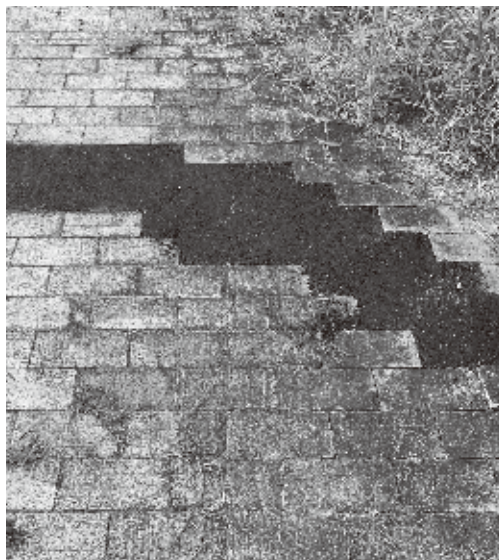
住民要望で補修がされた歩道
