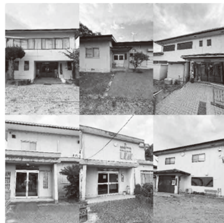
耐震化を待つ町内集会所6か所
