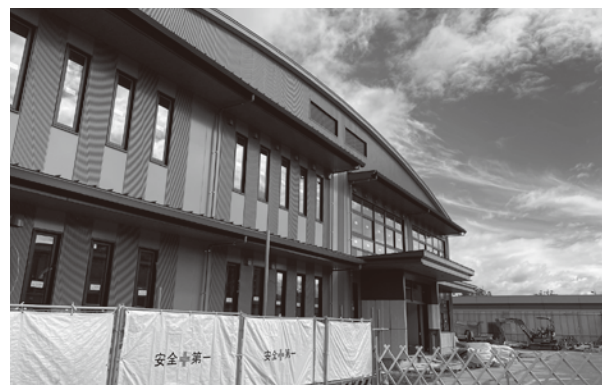
完成間近の防災保健センター
