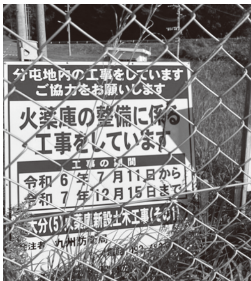
大分分屯地の工事標識（池田年宏氏から）
