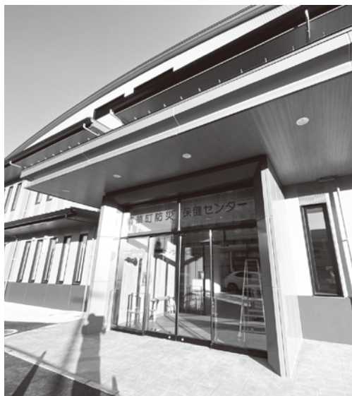
令和8年4月に新になる防災保健センター
