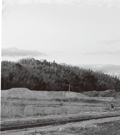
山積された祝園弾薬庫 増設工事の発生土砂
