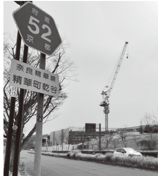
建設中のデータセンターは「打出の小槌」？
